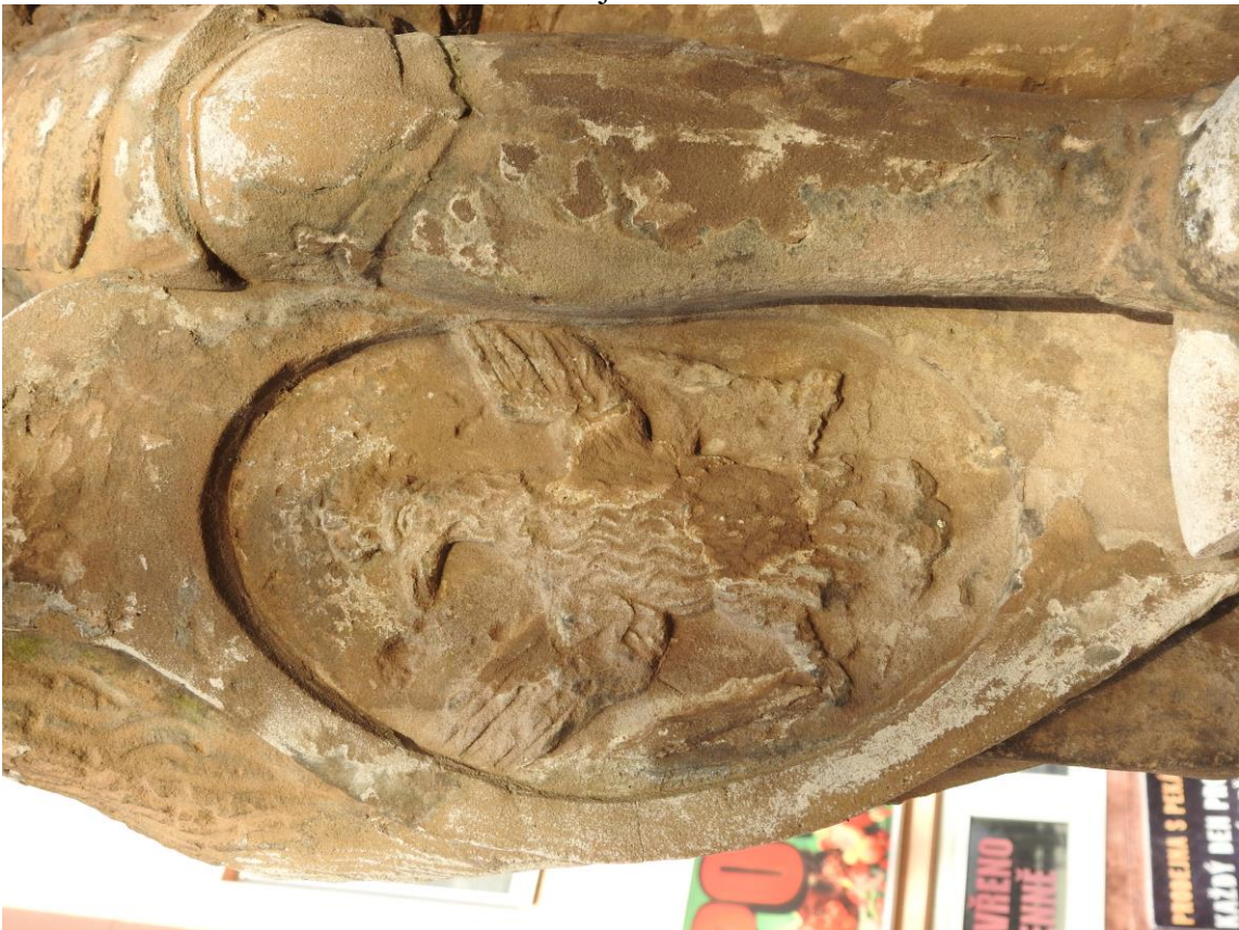
Praha-Dolní Chabry, pilíř se sochou sv. Václava, detail dolní části čelní strany sochy – stávající stav
