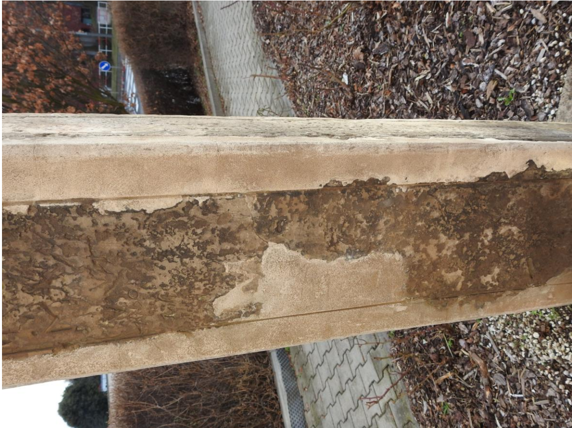
Praha-Dolní Chabry, pilíř se sochou sv. Václava, detail modelačních doplňků a rytých graffiti ve střední části zadní strany pilíře – stávající stav
