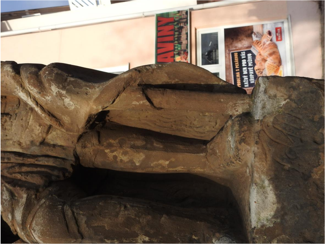
Praha-Dolní Chabry, pilíř se sochou sv. Václava, detail dolní části čelní strany sochy – stávající stav
