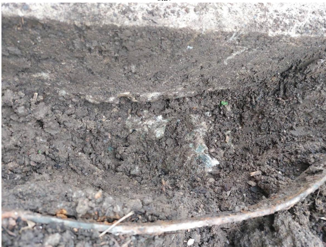
Praha-Dolní Chabry, pilíř se sochou sv. Václava, detail sondy do základu sochy – stávající stav
