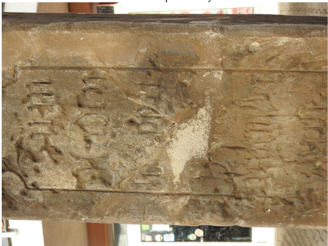
Praha-Dolní Chabry, pilíř se sochou sv. Václava, detail střední části čelní strany pilíře s německou částí nápisu – stávající stav
