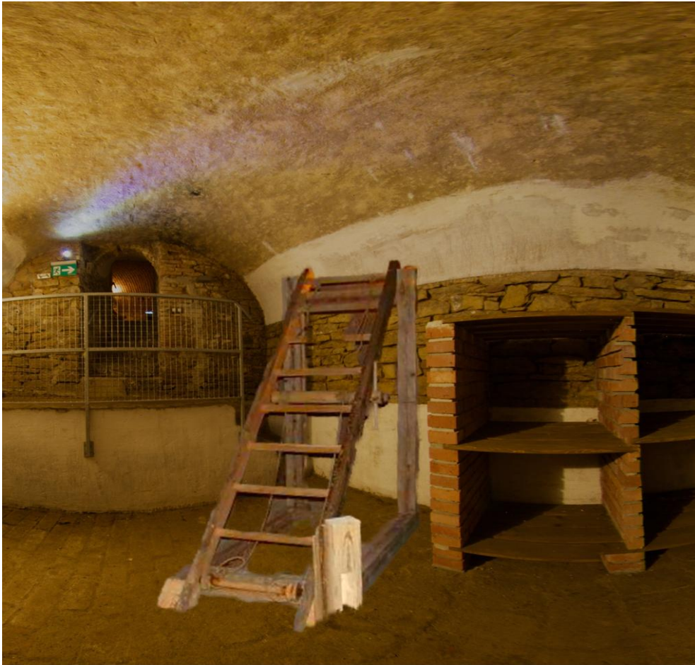
prvek přenosného schodiště v interiéru “hlavního sálu” sklepa pro řešení úlohy, načtení nápovědy ve výšce
