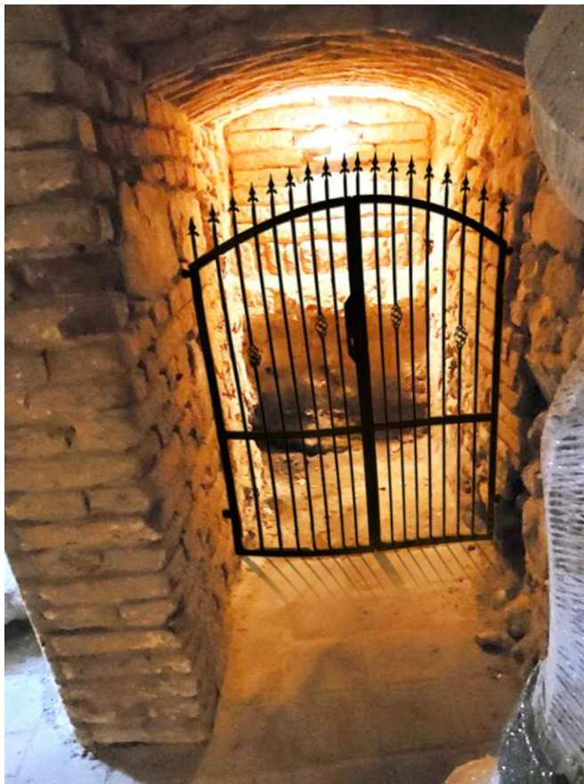
prostor zasypaná chodba s doplněnou mříží
