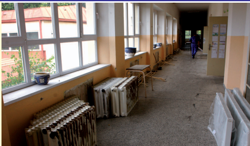
rekonstrukce topení v ZŠ
